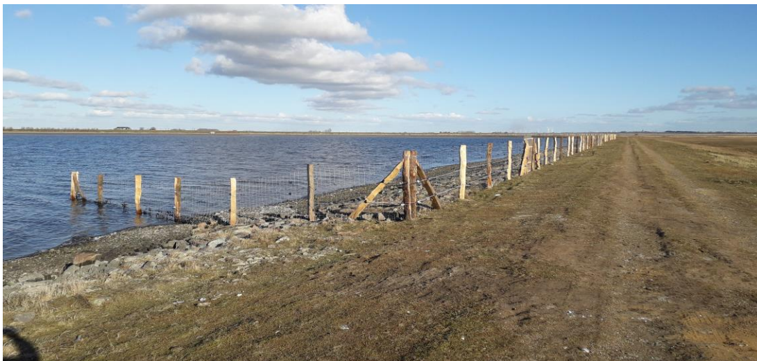
Abbildung 3 Westliches Ende des festen Prädatoren-Schutzzaunes im nördlichen Arlau-Speicherbecken von Westen gesehen. Der Zaun endet nach Norden hin in der Salzwasserlagune, um ein Umlaufen zu verhindern. Foto: D. V. Cimiotti
